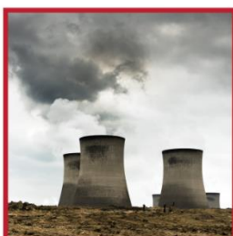
montowanie wydajnych filtrów kominowych
